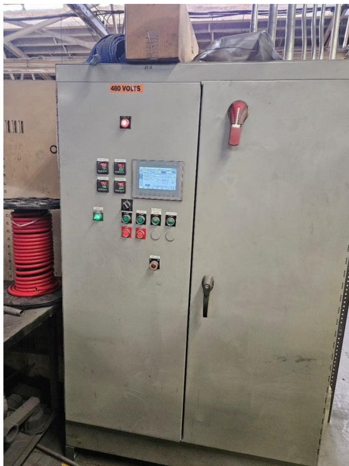
Foto n° 06 – Vista geral do painel elétrico equipado com interface homem-máquina (IHM) e controlador lógico programável (CLP) utilizado pela Agulhadeira modelo DI-LOUR II 25.
